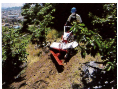
排土板を利用した造成
